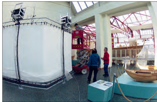
Fig. 3 Construction of the 360° Rotunda in the Museum für Antike Schifffahrt, 2012. – (Photo M. Orthwein).
