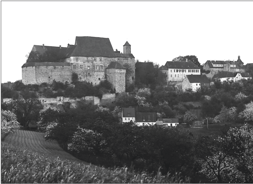
Abb. 1 Die Cadolzburg (Lkr. Fürth) vor der Zerstörung. – (Foto Bayerisches Landesamt für Denkmalpflege, AM2008_4_21_01014766).
