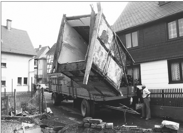
Abb. 8 Abtritt aus Feudingingen (Kr. Siegen-Wittgenstein), beim Abtransport. – (Foto G. U. Großmann).
