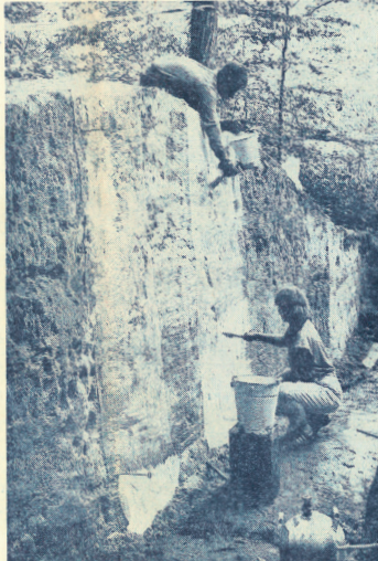
An der Erdwand, die mit Speziallack eingespritzt wird, drücken die Helfer feinen Mull auf. Die abgezogenen und auf Spanplatten aufge-
