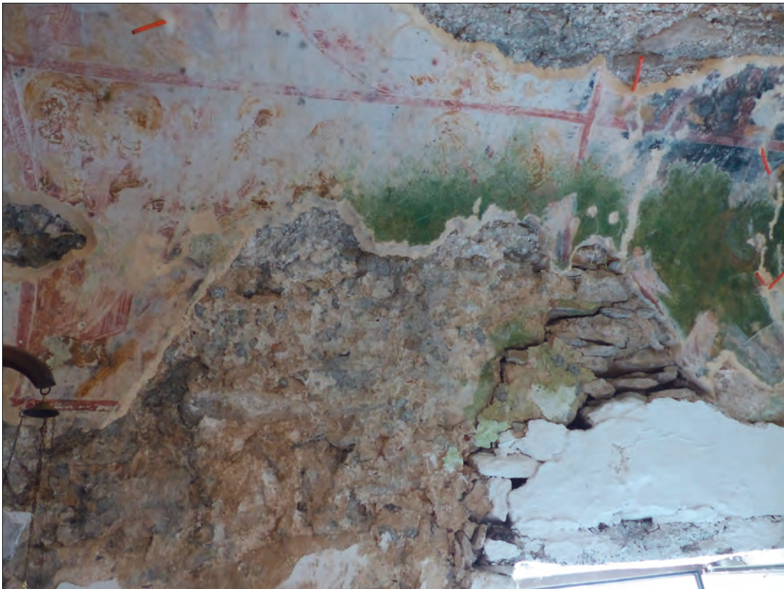
Hagios Ioannes-Kirche, Kentrochori: 1 Außenansicht der Nordseite. – 2 Risse und Wasserschäden über der Tür in der Südwand. – (Fotos J. Schmidt).
