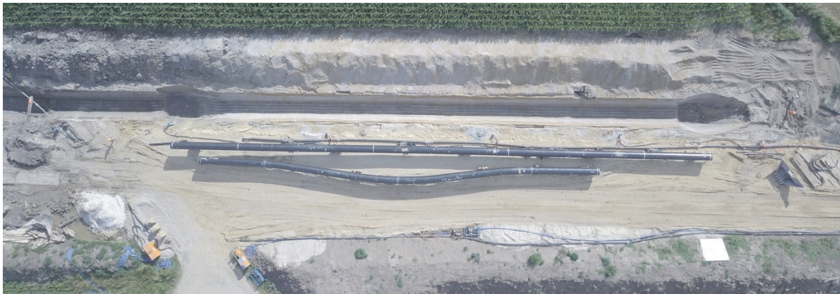
Abb. 27 Luftbild des Fundplatzes mit offenem Rohrgraben (Pro Arch GmbH, T. Muntean).
