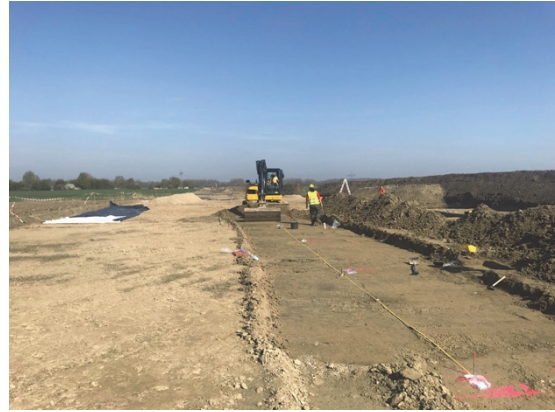
Abb. 14 Erste Sondierungen im Rohrgraben. Blick von Süden (Foto Pro Arch GmbH).
