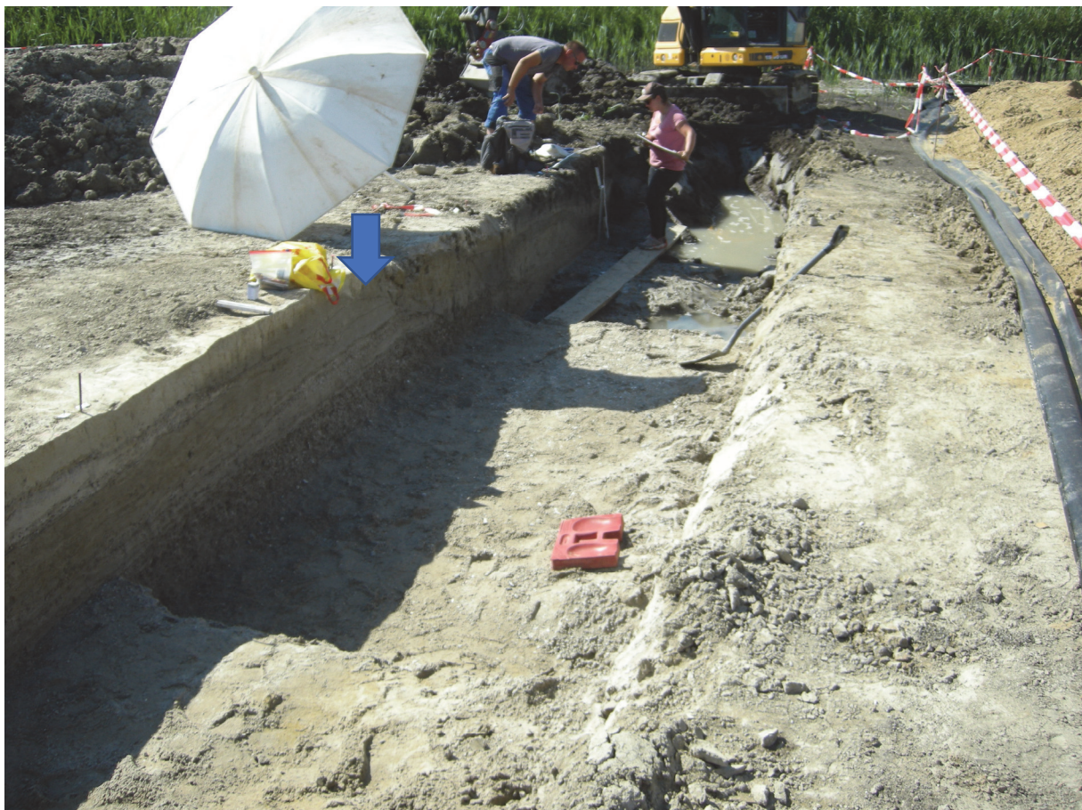
Abb. 22 Am nördlichen Rand der TM26 werden die horizontal gelagerten Kiese und Sande kurz vor der Profilstufe von tonigen und anmoorigen Ablagerungen einer Rinne geschnitten (siehe Pfeil).
