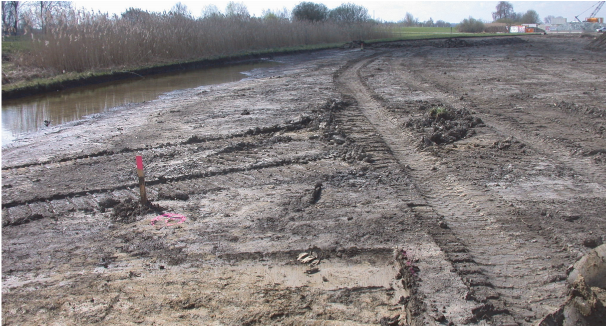
Abb. 6 Blick nach Südwesten auf das Planum 0 nach Oberbodenabtrag und dem Verlauf des Schallerbachs im Bereich des Schilfgürtels, links im Bild.
