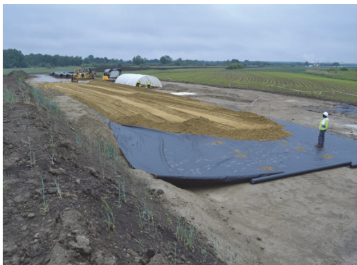
Abb. 17 Überdeckung des Fahrstreifenbereichs mit Geotextil und Sand (Foto Pro Arch GmbH).
