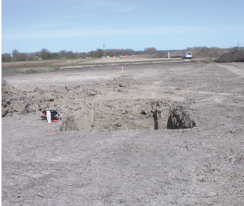
Abb. 11 Blick nach Nordwesten mit GS 70 in der Mitte der Fläche (geplanter Rohrgrabenbereich). Im Hintergrund ist der leicht erhöhte Kuppenbereich des bronzezeitliche Fundplatzes zu sehen.
