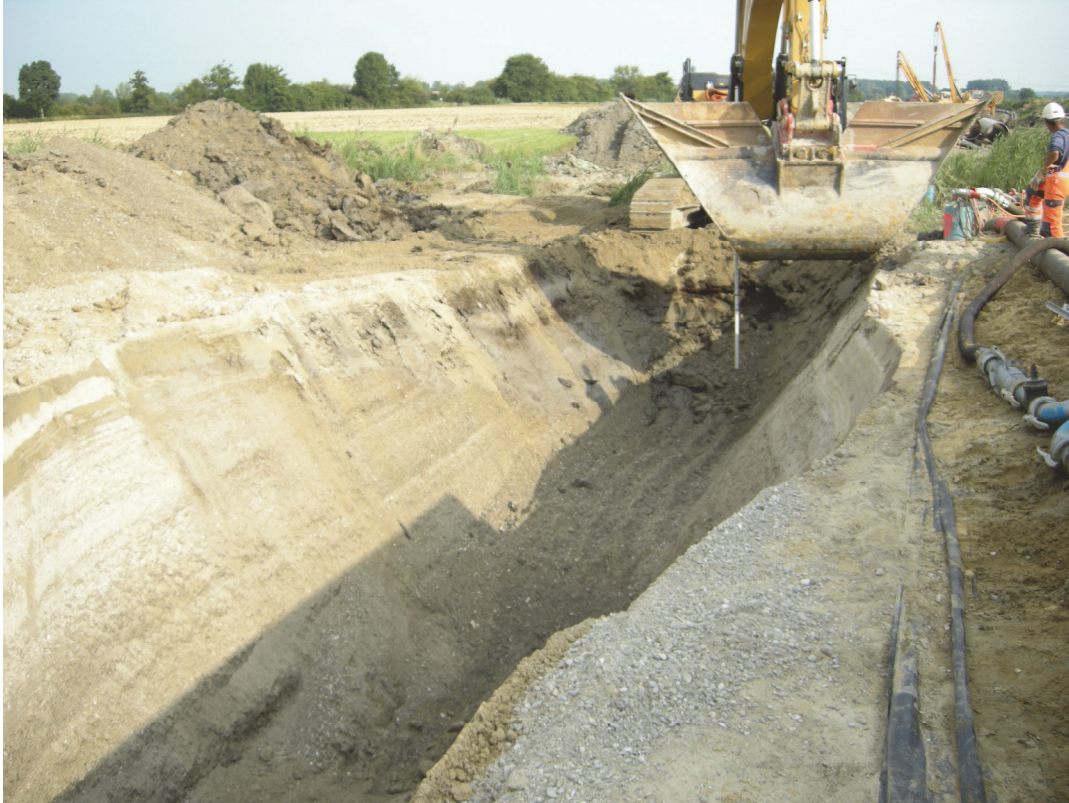
Abb. 27: Blick nach Nordwesten in den Rohrgraben im Randbereich des Fundplatzes. Hier sind die horizontal geschichteten und durch eine Rinne im Hintergrund gekappten Terrassenablagerungen gut zu erkennen. Kurz vor dem Bagger befinden sich die bei Profil 291 aufgenommenen Feuchtsedimente einer Rinne.
