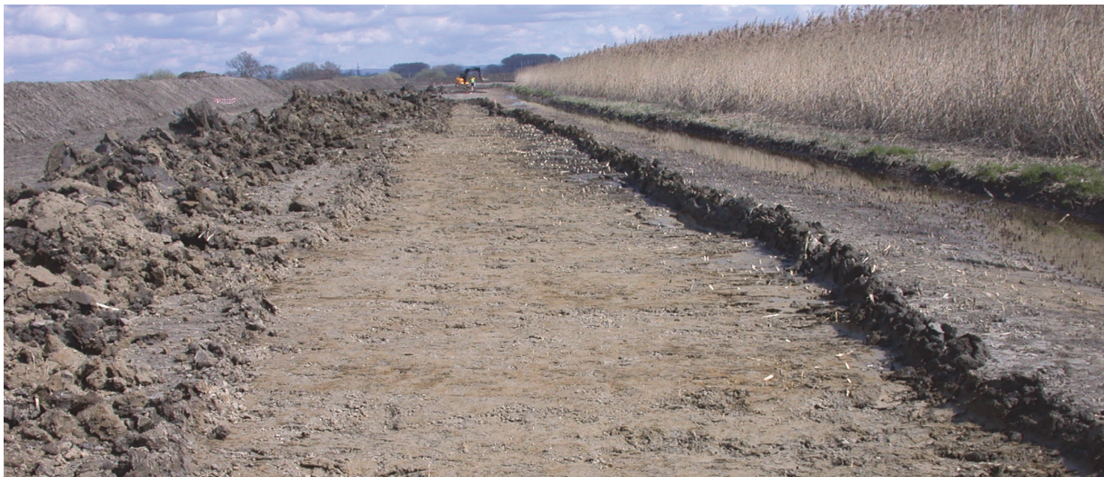
Abb. 7 Anlage der Rohgrabensondage Richtung Nordosten und dem Verlauf des Schallerbachs im Bereich des Schilfgürtels, rechts im Bild.
