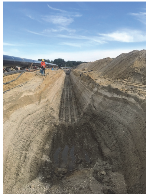
Abb. 29 Geöffneter Rohrgaben am Fundplatz, Blick von Süden, im Vordergrund ein sog. Kopfloch (Foto Pro Arch GmbH).
