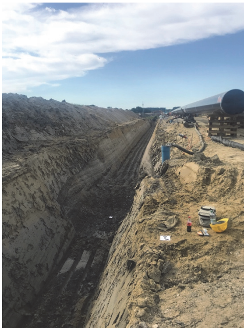
Abb. 28 Geöffneter Rohrgraben am Fundplatz, Blick von Süden (Foto Pro Arch GmbH).
