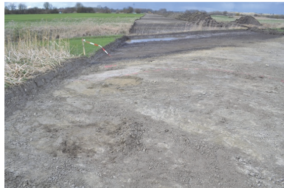
Abb. 8 Oberbodenabtrag am Fundplatz, FlstNr. 4811. Blick nach Norden (Foto Pro Arch GmbH).
