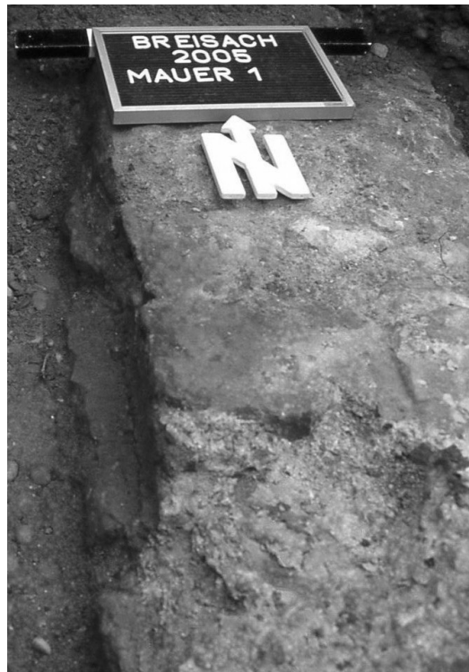
Abb. 13 Breisach, Münsterplatz. Das aufgehende Mauerwerk verjüngt sich von 90 auf 60 cm im so genannten Fundamentvorsprung. Dieser dient auch als Auflage für Fußböden. Damit stellt das Prætorium einen absoluten Sonderfall dar, was die Erhaltung römischer Bausubstanz in Breisach angeht.
