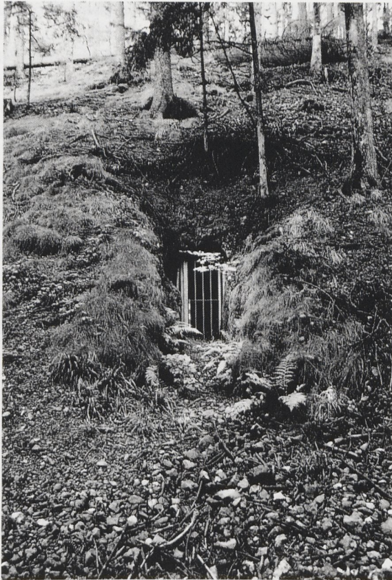
Abb. 5 Mundloch der Antimongrube "Victoria" mit Fledermausgitter (Foto 1994).
