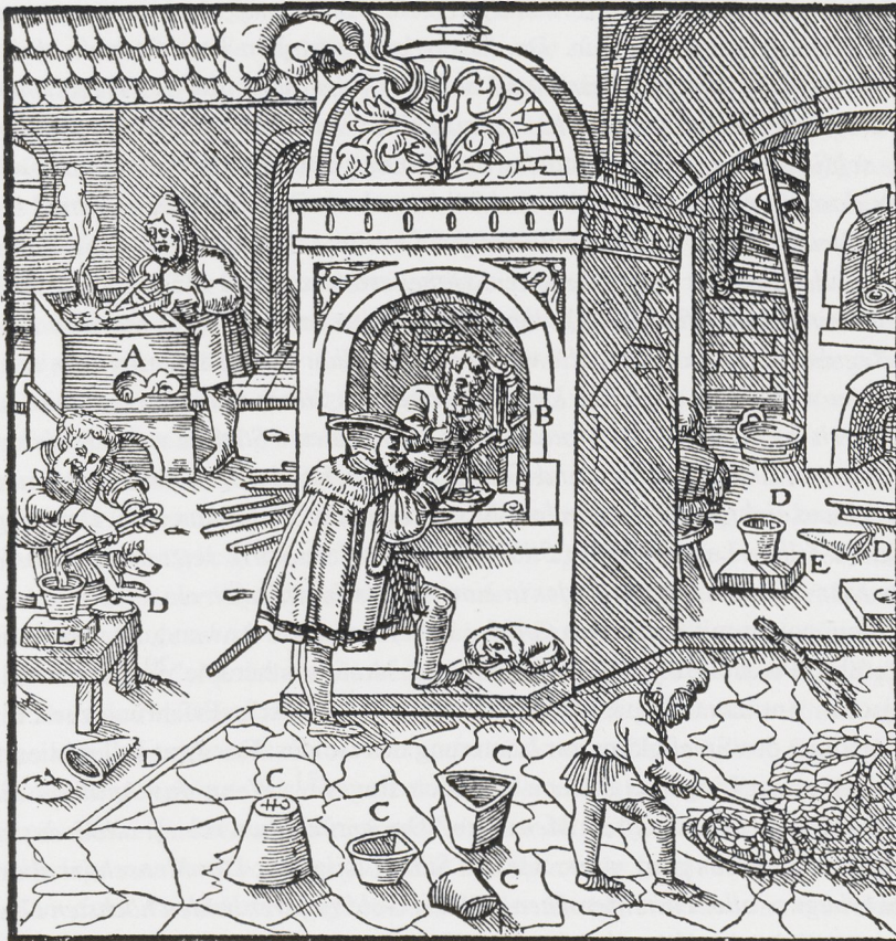
Der Windofen A. Der Goldschmiedeofen B. Der Tontiegel C. Der Eisentiegel (Gießbuckel) D. Der Klotz (Stock) E.
