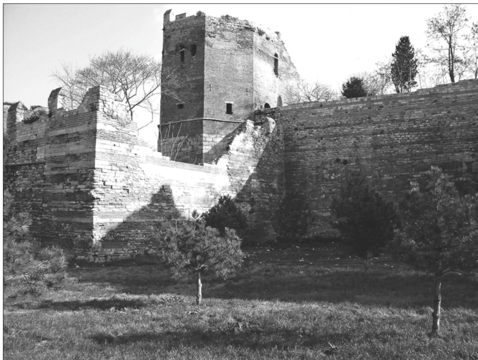
Abb. 7 L-förmige Erweiterung des Leon-Vorwerks von Südwesten. – (Foto N. Asutay-Effenberger).
