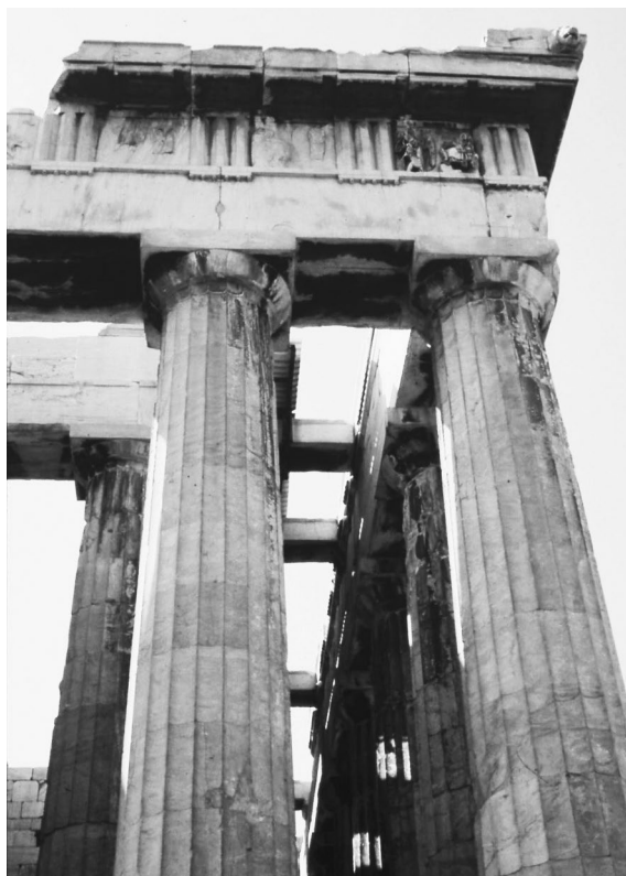
Fig. 5: Il Partenone di Atene, particolare del sistema costruttivo colonna-echino-abaco-trabeazione.
