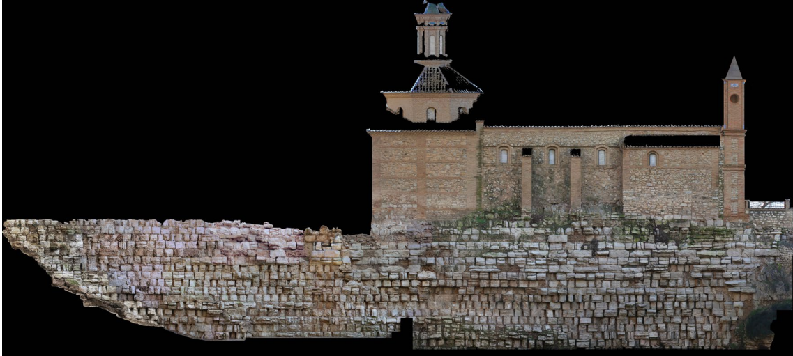
Fig. 2: Alzado de la presa romana de Muel.
