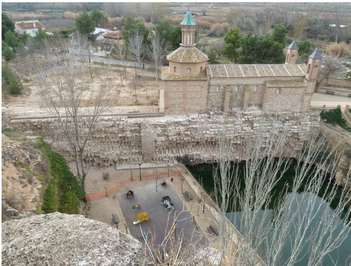
Fig. 1: Estado actual de la presa romana de Muel (Zaragoza, España).
