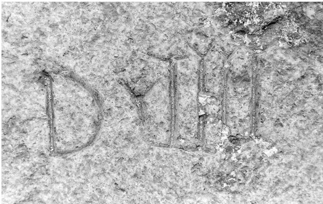
Fig. 8: Teatro de Cartagena. Siglas de localización y posicionamiento de los tambores de fuste.
