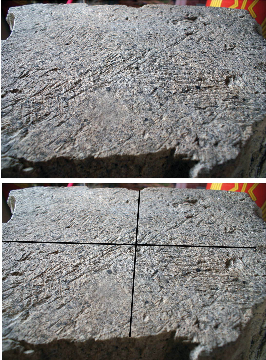
Fig. 1: Trazos de diseño sobre elemento arquitectónico estructural.
