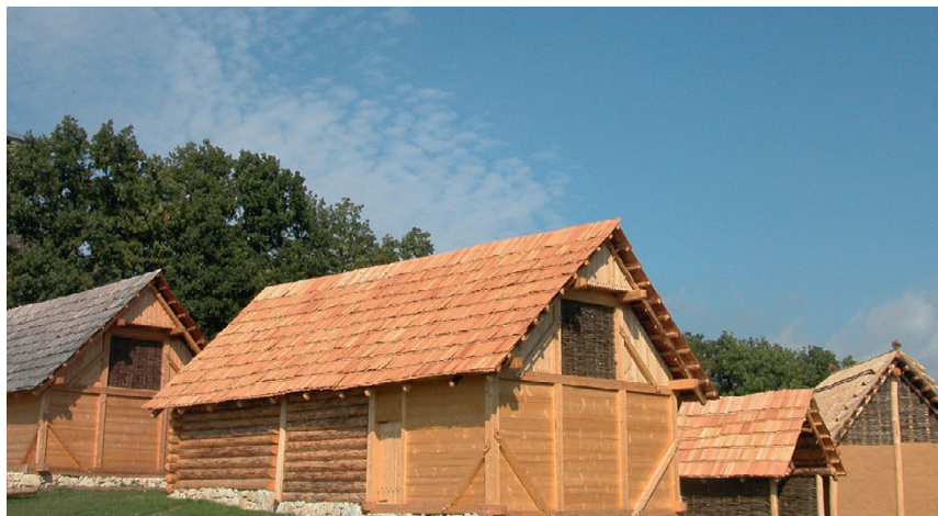
18 Das eisenzeitliche Freilichtgelände am Burgberg von Schwarzenbach von Süden. Im Vordergrund ein Wohnhaus in Mischbauweise aus Schwellen-, Pfosten- und Blockbau, in welchem Besucher auch übernachten können.
