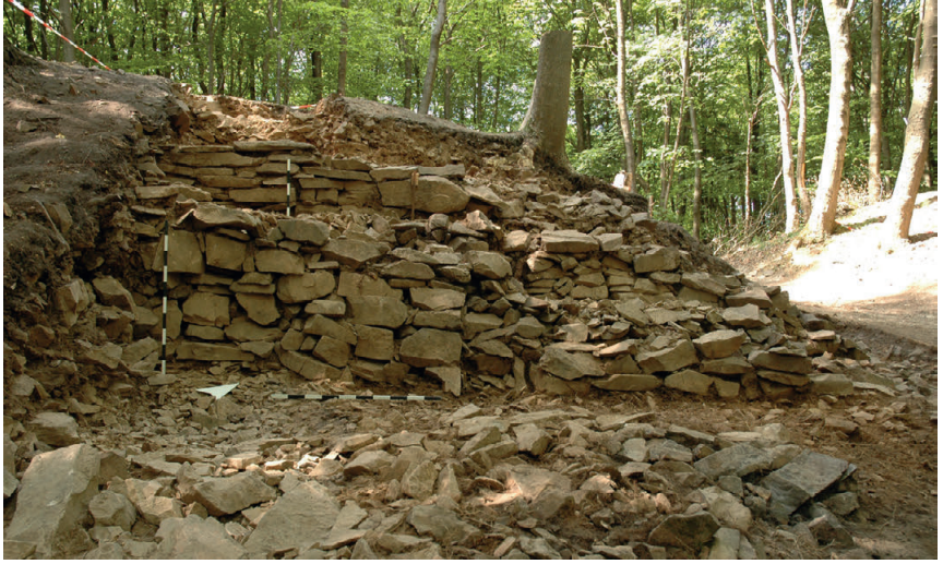
15 Südwall, Zangentor. Die freigelegten drei Mauerphasen der Befestigung im Bereich der westlichen Torzangenecke.
