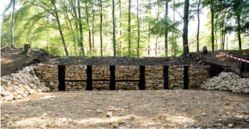
14 Zwischenwall. Die wiederaufgebaute Mauer nach Beendigung der Arbeiten.
