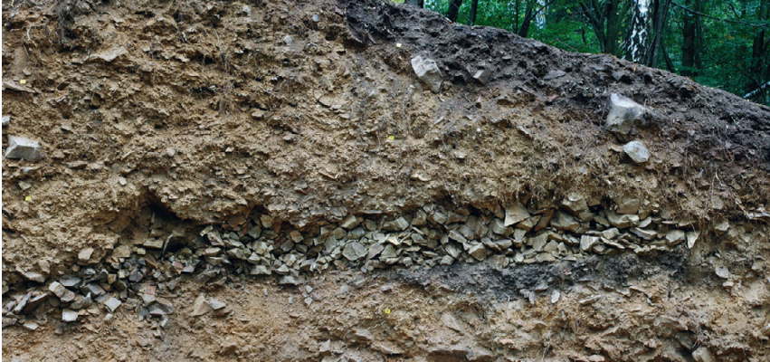
7 Mittelwall. Blick auf die rückwärtige Wallrampe mit der Drainageschicht aus kleinstückigen Rhyolithbrocken.
