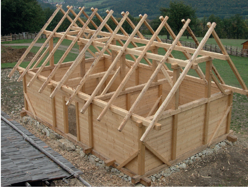
13 Rohbau eines Wohngebäudes im keltischen Freilichtmuseum am Burgberg in Schwarzenbach in der „Buckligen Welt“ mit Schwellbalkenkranz, Wandständern, Riegelwänden, Pfettenhölzern und Rofenbäumen; manche Gebäude waren bereits in der Eisenzeit innen in mehrere Räume unterteilt.
