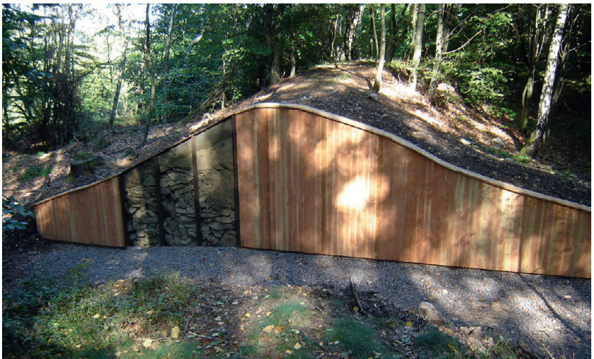
8 Das fertige Profil mit Holzverkleidung und Glasfenster vor den Mauerfronten.
