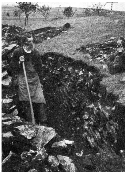
4 Grabungsschnitt 1906 entlang der östlichen Torwange von Zangentor F. Zu erkennen ist das Pfostenschlitzmauerwerk mit etwa meterbreiten Mauersegmenten.
