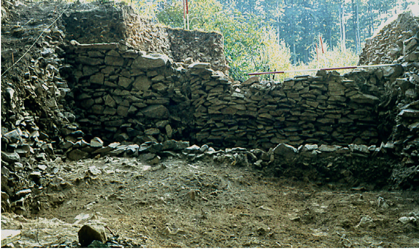
2 Reste der zwei voreinanderstehenden Mauern des Ostwerkes in einem der Schnitte von Engels.
