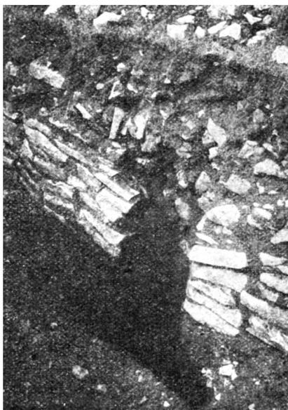
5 Grabung 1906 an der Ostseite von Tor F. Neben den senkrechten Pfostenschlitzfenstern deutet sich in der Mauerfront eine waagrecht verlaufende steinfreie Lücke an. Hertlein vermutet darin liegend verbaute Hölzer.
