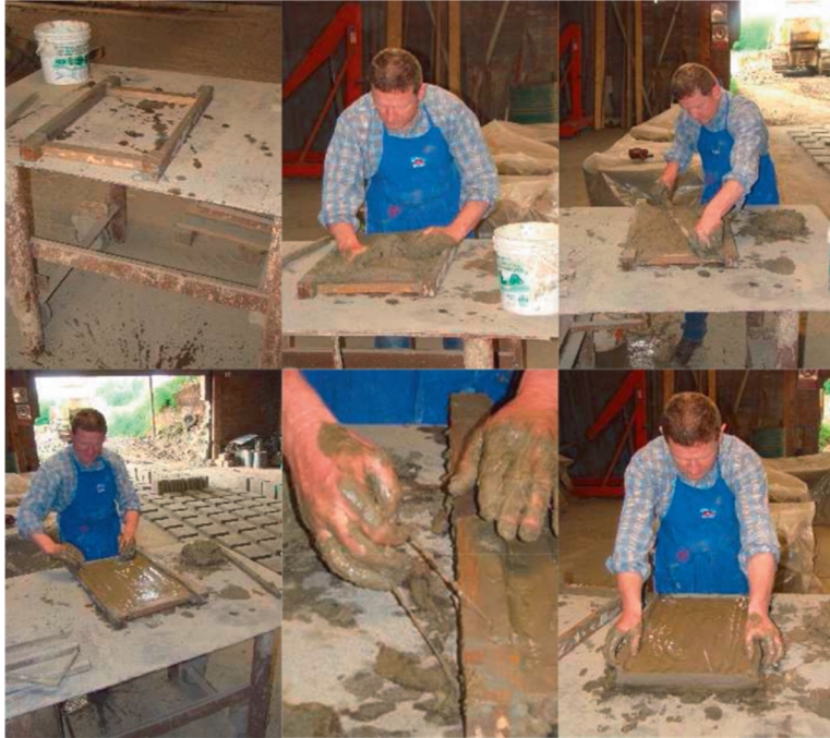
Abbildung 34 Ablauf beim Formen der Dachziegel für Gebäude des archäologischen Parks in Xanten (Kienzle 2011)
