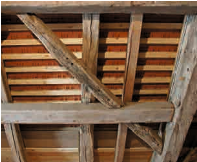
227 Möglicher Sparrenrest von 1330 mit der Blattsasse für einen Kehlbalken oder ein Sparrenfußband.
