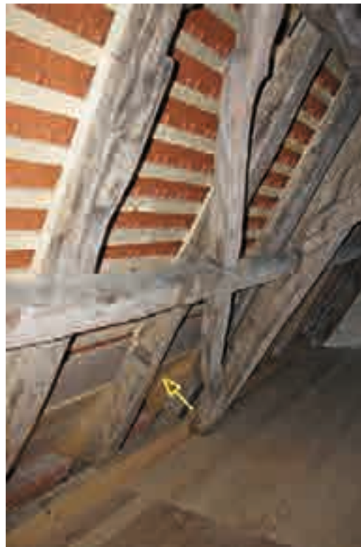
225 Blattsassen (Pfeil) an dem als Sparren 14-Nord verbauten Dachbalken von 1330 (d13: Sommerfällung 1330).
