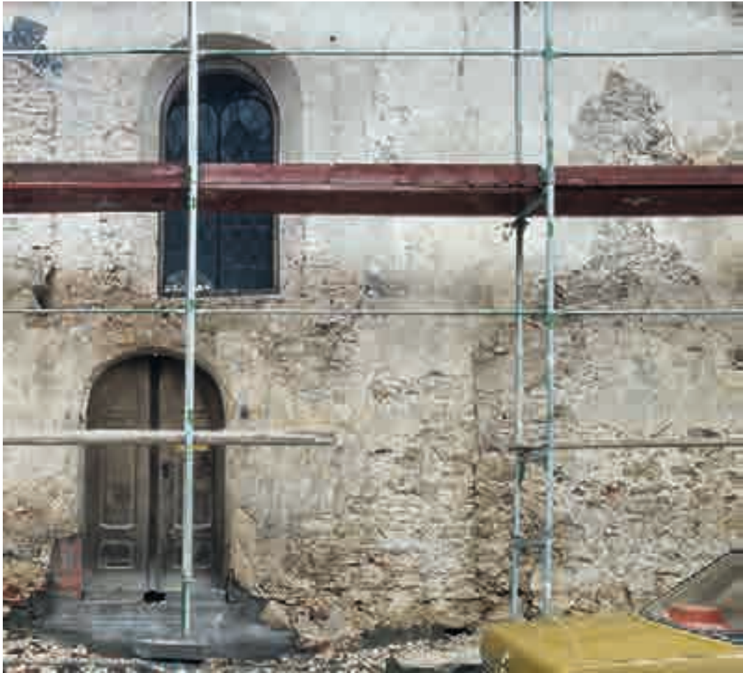
136 Ansicht der mittleren Südfassade 1981. Über dem Autoheck ist die Fuge zwischen dem Wohnturm des späteren 15. Jahrhunderts (rechts) und dem Kirchenbau von 1589 (links) zu erkennen. Aus der Bauzeit der Kirche stammen der Eingang und die zugesetzten Fenster, jeweils mit Resten von Quaderbemalung.
