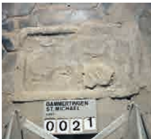
159 Schnitt 3, Profil 14 von Südosten. Im Zentrum die oberen Lagen der Fundamentschüttung IV fm 4, mit der die ursprünglich ungenügend fundamentierte nördliche Chorbogenwand IV am 4 unterfangen wurde.
