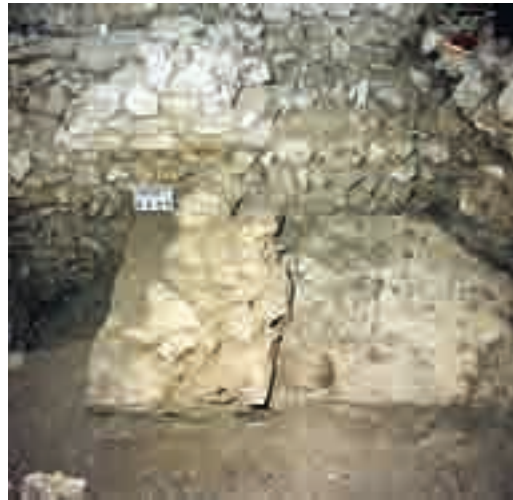
65 Schnitt 8, Fläche 6, Ostteil, von Norden. Untere Lagen der Trockenmauer B am, welche die humose Unterfüllung B ps 2 (links) gegenüber dem zwischen den Hügeln der Flachmotte gelegenen „Graben“ (rechts) abstützt.
