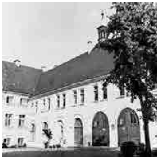
151 Der ehemalige Fruchtkasten (Fassade 18. Jh.) und seine „Einmündung“ in das klassizistische Stadtschloss, von Westen.
