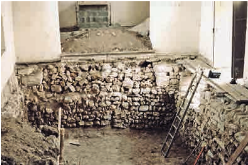
95 Blick von Westen in das Langhaus. Die meisten der sichtbaren Mauern und Fundamente gehören in die zweite Kirchenphase. Zum Chor hin bilden II fm 1 (links) und II fm 2 gemeinsam das Spannfundament, auf dem die Chorbogenpfeiler II am 1 und 8 (Letzteres über lokaler Fundamentierung II fm 10) gegründet sind. II fm 2 dient auch als Spannfundament zum südlichen Seitenschiff. Vor der Lücke zum ehemaligen Seitenturm (vor II am 1) ist der erste Arkadenpfeiler II am 2 zu erkennen, an den weiter westlich Füllmauerwerk der dritten Kirchenphase anschließt, wie es sich auch unter dem Chorbogen zwischen II am 1 und 8 findet.
