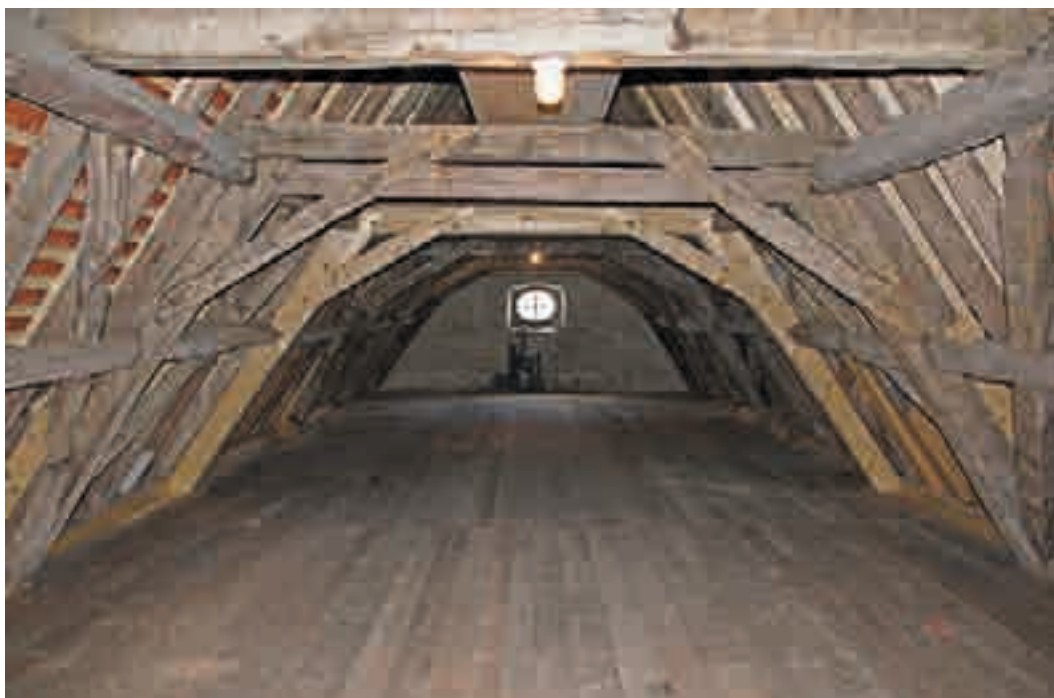
223 Blick in das jüngst erneuerte Dachwerk der Michaelskirche nach Osten.
