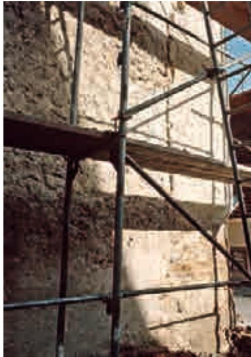
122 Südwestecke der Michaelskirche, von Nordwesten. Deutlich ist die Baufuge zwischen dem älteren Natursteinmauerwerk im Norden und der aus Backstein angefügten Süderweiterung von 1589 zu erkennen.
