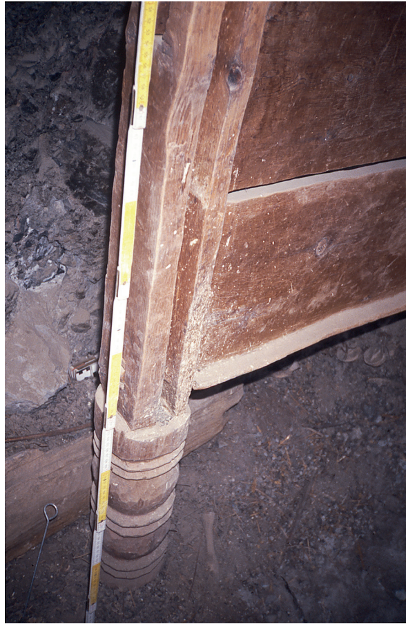
Abb. 3.12 Stelle 633. Nordwest-Pfosten mit Längsnut und Fußgestaltung.
