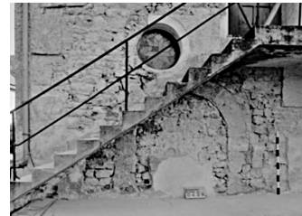
Abb. 25 Ehemalige Türelemente auf der Südseite des Kirchenschiffs von St. Vitus in Schmiechen, heute zugeputzt.
