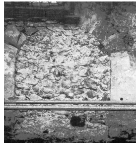
Abb. 24 Ehemalige Türelemente auf der Südseite des Kirchenschiffs der Dreikönigskirche in Deggenhausertal-Urnau, BW, nach Entfernung des Außenputzes.
