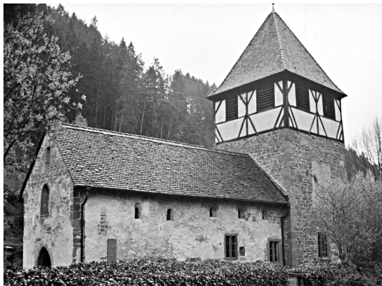
Abb. 19 Hochgestellte romanische Fenster in verschiedener Position neben später eingebrochenen im Kirchenschiff der Chorturmkirche St. Candidus in Kentheim, BW (2005).
