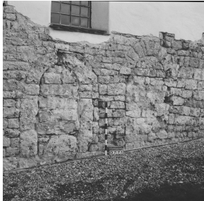
Abb. 23 Ehemalige romanische Türelemente in der südlichen Kirchenschiffsmauer von St. Peter und Paul, Nusplingen, während der Arbeiten am Außenputz.
