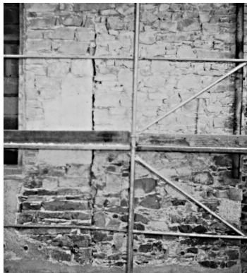
Abb. 26 Baufuge in der nördlichen Kirchenschiffsmauer St. Georg, Burladingen.
