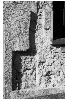
Abb. 27 Baufuge am Kirchenschiff (Nordwand) von St. Vitus in Schmiechen.
