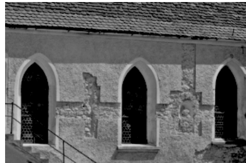
Abb. 20 Romanische Fensterreste in der Südwand von St. Vitus in Schmiechen zwischen den neuzeitlichen regotisierten Fenstern, nach partieller Entfernung des Außenputzes.
