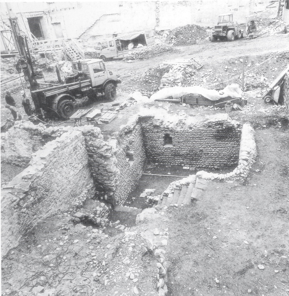
Abb. 2 Grünwälderstr. 16/18 (»Harmonie«); Blick über die Grabung 1990: vorne der Steinkeller eines Holzhauses (1. Viertel 12. Jahrhundert), das für den Bau des Stadtmauer-Rondenwegs abgebrochen wurde (Foto Landesdenkmalamt Baden-Württemberg).
