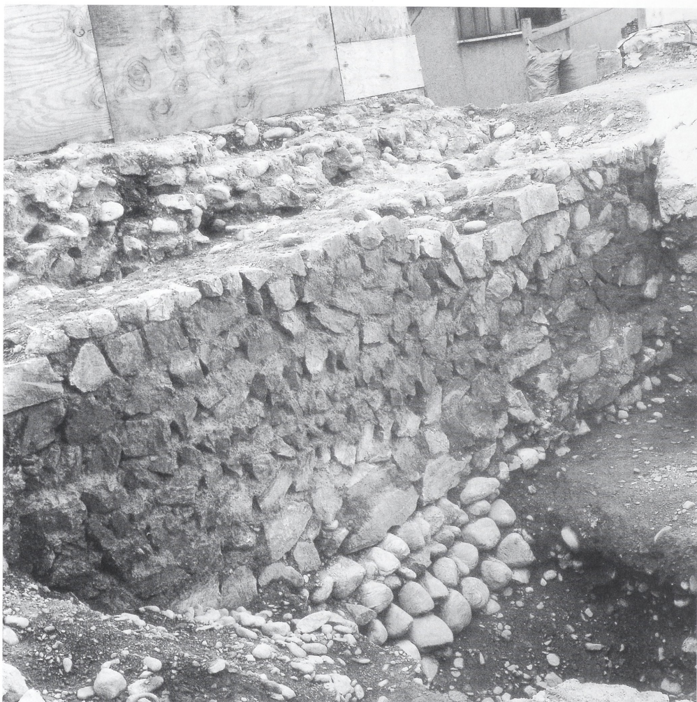
Abb. 3 Grünwälderstr. 16/18 (»Harmonie«), Stadtmauer; sie zieht mit einem breiten Wackenfundament quer durch den verfüllten Kellerraum eines älteren Holzhauses (Foto Landesdenkmalamt Baden-Württemberg).
