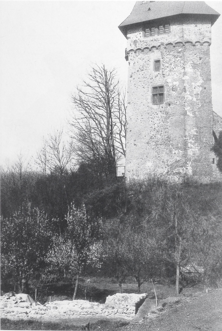
Abb. 27 Jechtingen, »Sponeck«. Restauriertes Fundament eines spätantiken Kastellturms, im Hintergrund Palas der mittelalterlichen Burg.
