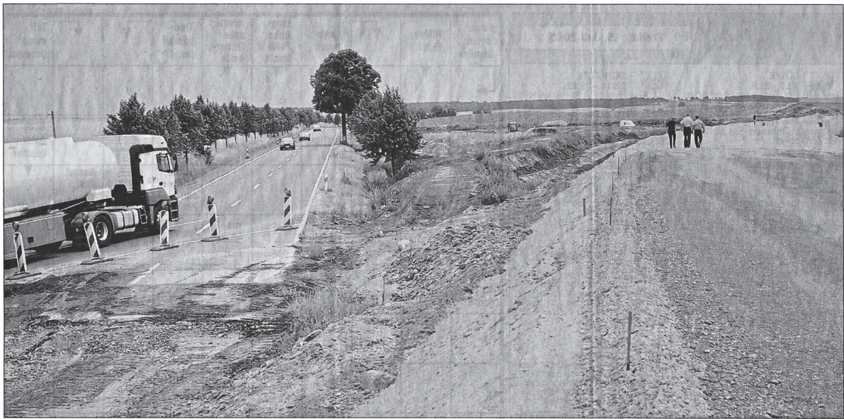
Die Archäologen sind längst verschwunden: Bevor die Bagger anrückten, untersuchten Historiker das gesamte Erdreich unter der neuen Ortsumgehung von Passow. Links ist die alte Trasse zu sehen, rechts wächst bereits die neue Piste über das Welsebruch hinweg. MOZ-Foto: Karl-Heinz Wendland
