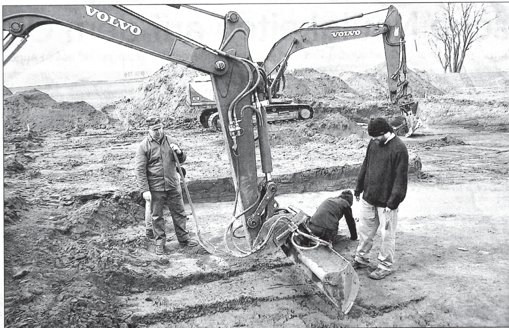
Archäologie mit Baggerhilfe: Fast millimetergenau schrapt der Greifer über das Erdreich. Ihm folgen die Grabungstechniker, die Einzelfunde bergen und Siedlungsreste sichtbar machen. Fotos (2): O. Schwerts
