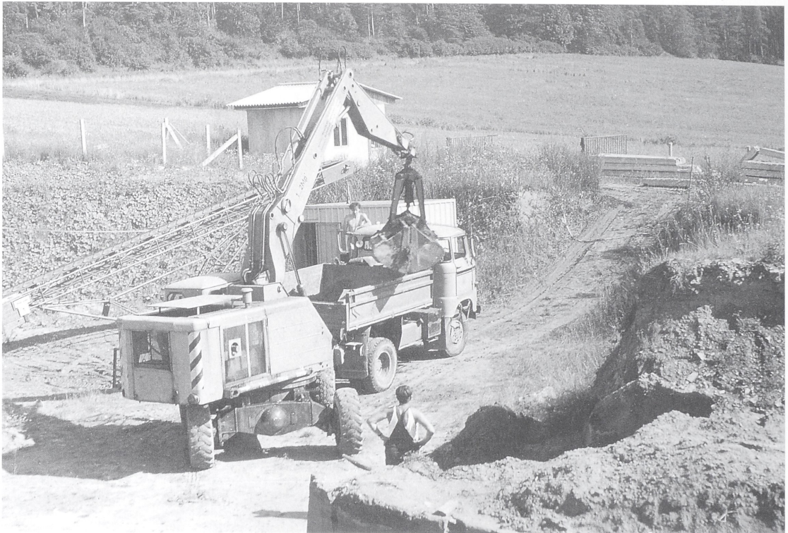
Abb. 8 Einsatz von Technik der Zentralen Bauorganisation Obermaßfeld/Salzbrücke an der Fundstelle Untermaßfeld, Blick von NW, August 1987 (Foto: J.-A. Keiler).
