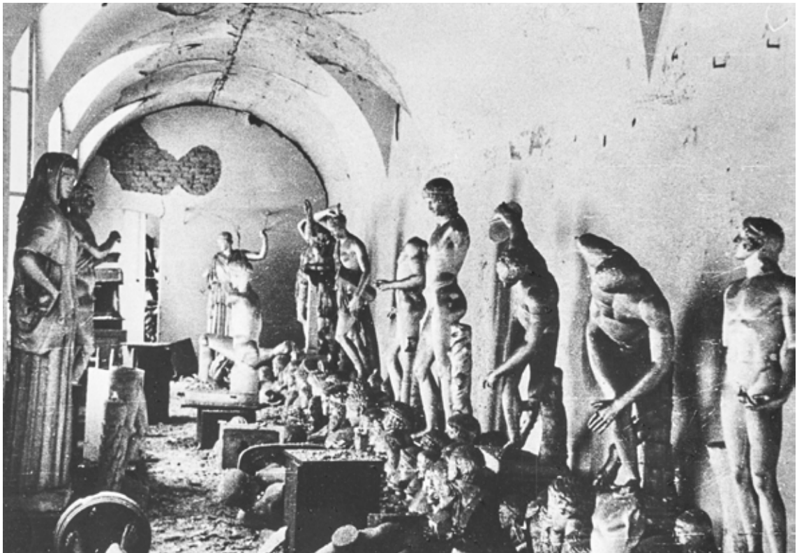
Blick in einen Raum des Museums nach Bombentreffern 1944/45 im Erdgeschoss
