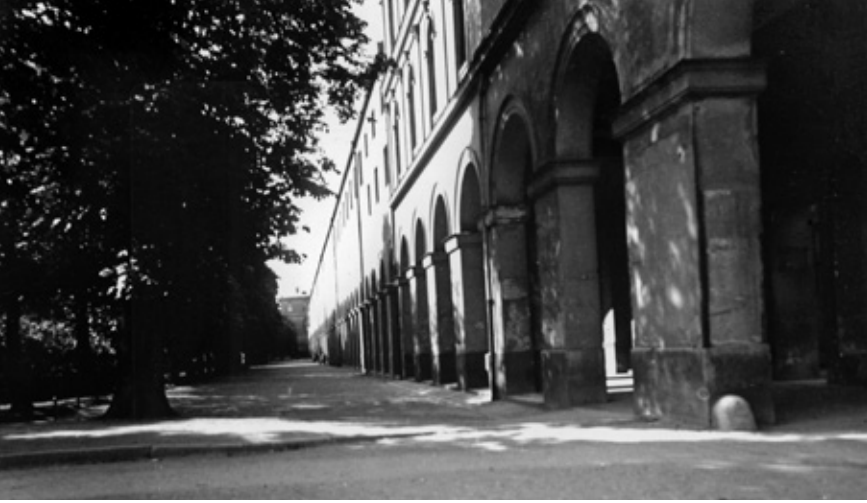
1877 zogen die Abgüsse in Räume der nördlichen Hofgartenarkaden.
