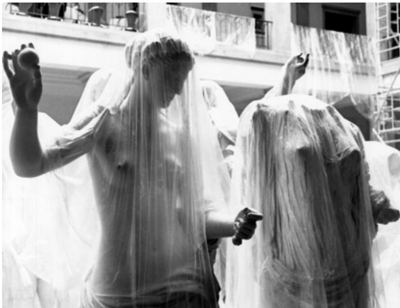
Sanierung der Glasdächer in den beiden Lichthöfen
