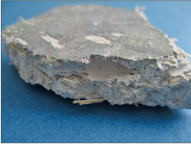
Abb. 7 Çanlı Kilise. Putzgrund mit Holzspänen. – (Foto R. Warland).
