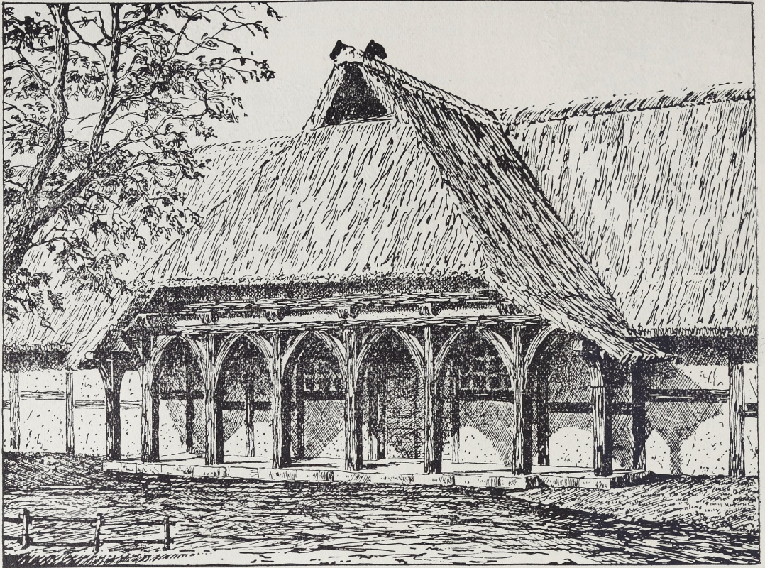
Abb. 8. Vorbau an der Nordseite des Langhauses.
