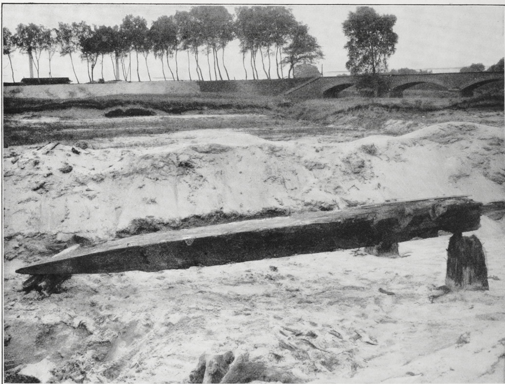
Abb. 12. Haltern, Ostseite. Reste einer Brücke über die Steverniederung. Ein hochgewundener Ramppfosten. Für die Maße vergl. Zollstock auf dem Pfahl rechts.
