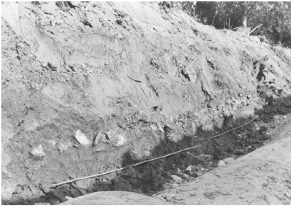
148 1969 durchgeführte Baubeobachtung der Straße Schallstadt-Wolfenweiler (S 20), Fotografie der Bruchsteinstückung des Fahrbahnkörpers.
