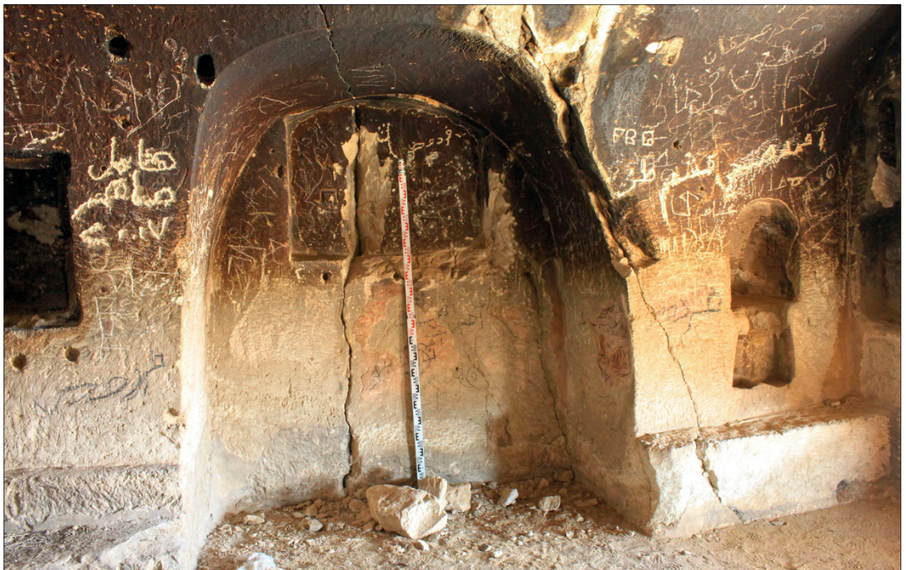
Abb. 9 Apsis und Wandnische in der Ostwand des Oratoriums von Ġazal. – (Foto F. Abou Sekeh 2011).
