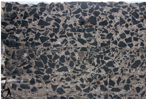
Abb. 2 Schnitt durch das Fundament.
