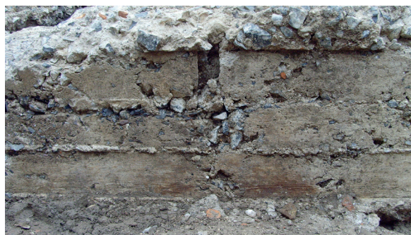
Abb. 14 Drei Schalbretter im Bereich links und rechts von Holz 2. Bretthöhe ca. 30 cm.
