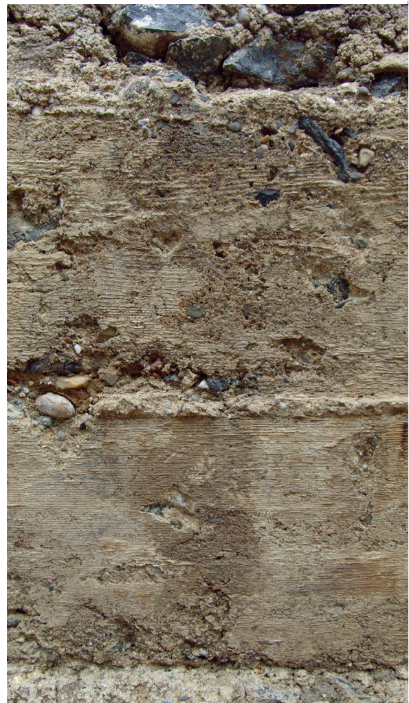
Abb. 16 Unteres und mittleres Brett im Bereich zwischen Holz 3 und 4. Das untere Brett wirkt engeringiger als das mittlere. Bretthöhe ca. 30 cm.
