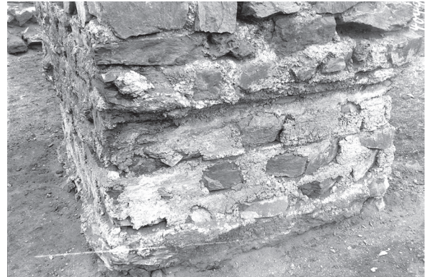
Abb. 4 CUT, Insula 40, Amphitheater, Fundamentpfeiler 55 mit Schalungsabdrücken.
