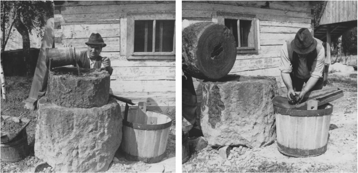
Abb. 133: Handbetriebene Erzmühle im Siebenbürgischen Goldbergbau. Im geöffneten Zustand sind das Mühleisen im Läufer- und das Zapflager im Bodenstein sichtbar. (Roșia Montană, Kr. Alba, Rumänien) Aufnahmen von Bazil Roman (vor 1948).
