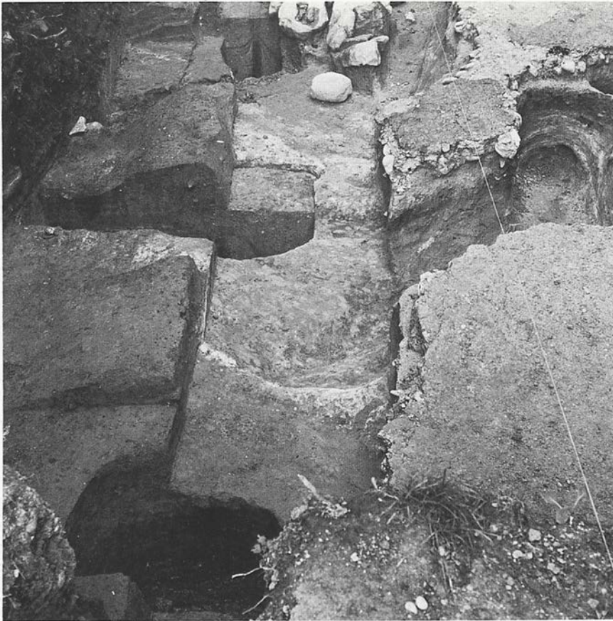
35 Klosterwestflügel. Pfostengruben der Kreuzgangwand des Holzbaues zur Hälfte geöffnet mit Pfostenstümpfen (links); der ausgeraubte Fundamentgraben des gemauerten Nachfolgebauwerks II schneidet in die Befunde I und den gewachsenen Boden ein; rechts die wieder geöffneten Sondierschächte Reissers und der Kreuzganggestrich II; von N her
