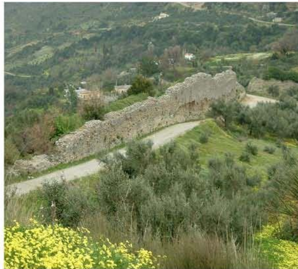
Abb.14 Kreta, röm. Aquädukt
