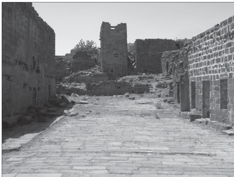
Abb. 7 Saccaea, »Kaisariye«, Hof mit ehemaliger Tempelterrasse und neuzeitlichem Turm. – (D-DAI-ROM-2011.1569, Foto P. Grunwald, digitale Bildbearbeitung H. Behrens, D. Gauss, G. Barbat).
