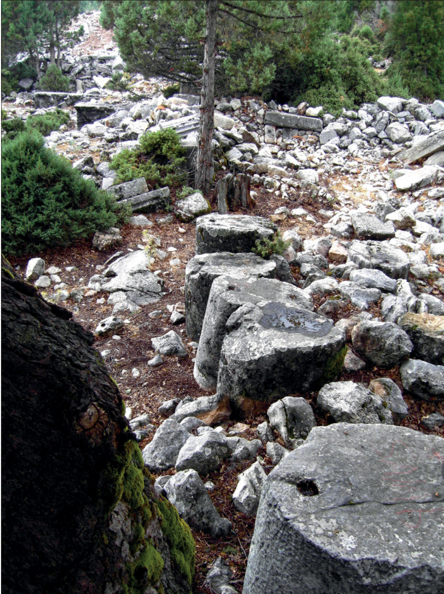
Abb. 12 Nordstoa der sog. Esplanade, sekundär vermauerte Joche der Säulenstellung. – (Foto Verf.).
