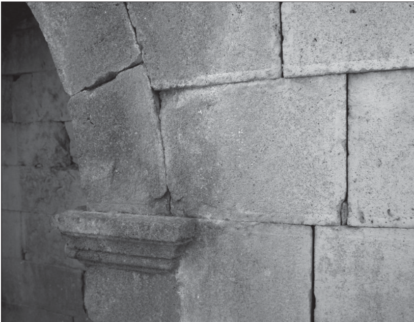
Abb. 10 Saccaea, »Kalybe«, Nordfront, Bogen der unteren Nische, Keilsteine aus wieder verwendeten Quaderblöcken. – (D-DAI-ROM-2011.1728, Foto P. Grunwald, digitale Bildbearbeitung H. Behrens, D. Gauss, G. Barbat).
