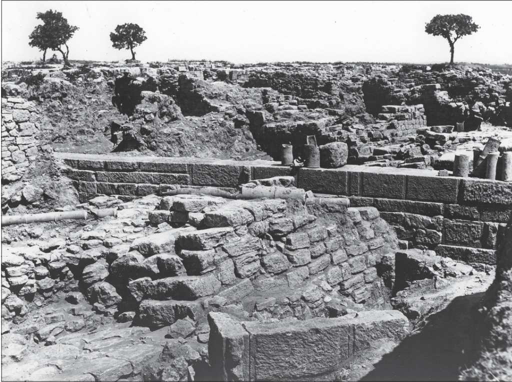
Abb. 15 Fundamentzone und untere Lagen des aufgehenden Mauerwerks der Außenwand der Südportikus in den Planquadraten HJK 8. Von Süden aufgenommen. – (Nach Grabungsfoto Dörpfeld, DAI Athen, Troja Neg. 547).
