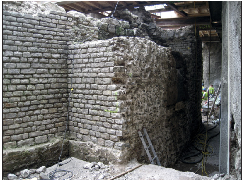
Abb. 3 Köln, Kurt-Hackenbergs-Platz. Unterbau des nördlichsten Torhauses an der Innenseite der römischen Stadtmauer entlang des Rheins. – (Foto RGM, A. Schäfer).
