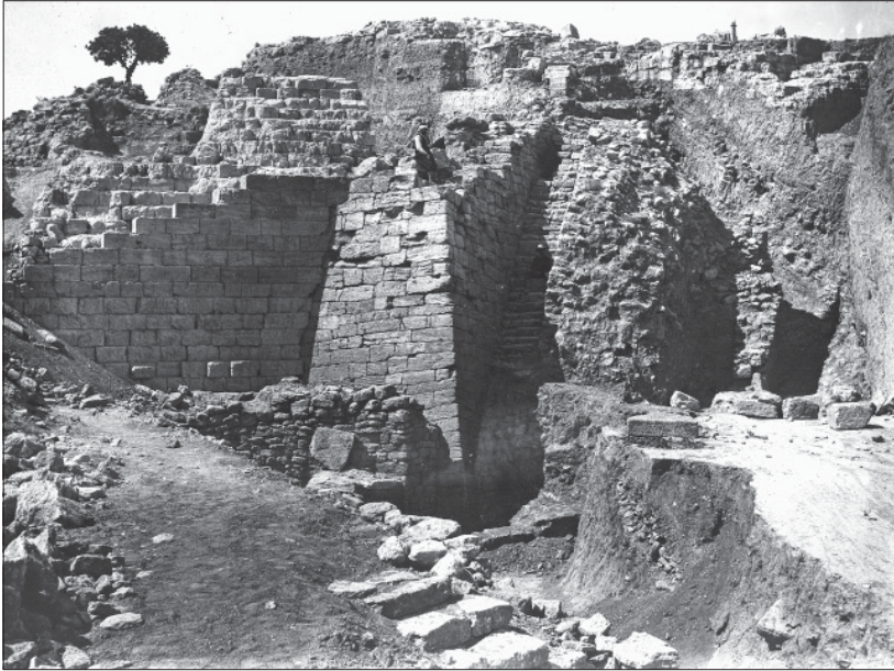
Abb. 5 Ansicht der Nordecke der Nordostbastion und anderer Bauten in den Planquadraten JK 3. Leicht von Nordosten aufgenommen. – (Nach Grabungsfoto Dörpfeld, DAI Athen, Troja Neg. 546).
