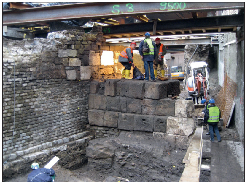
Abb. 4 Köln, Kurt-Hackenbergs-Platz. Teilstück der römischen Stadtmauer auf Höhe des Hafentores. Ein Abwassersammler verläuft durch den Unterbau des Torhauses. – (Foto RGM, A. Schäfer).
