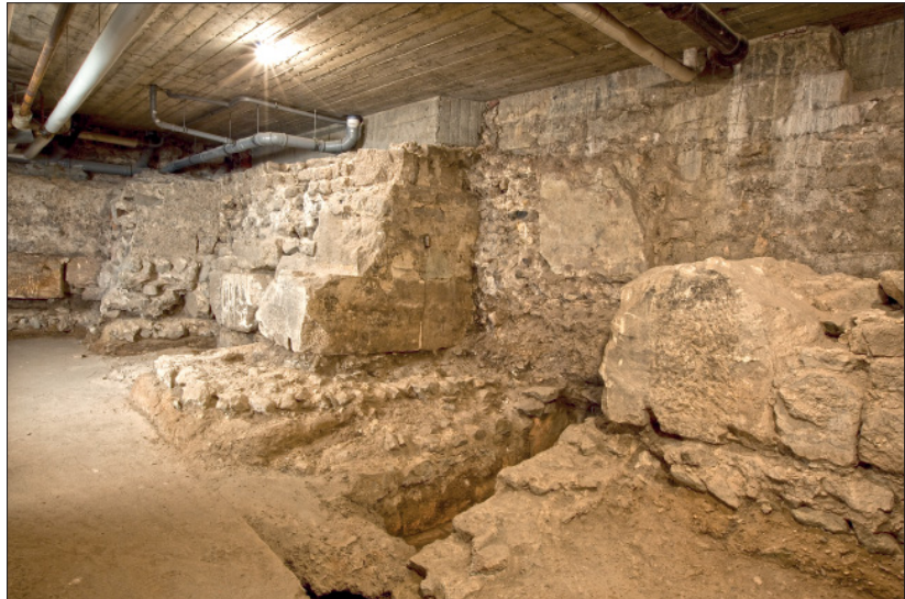
Abb. 9 Köln, St. Maria im Kapitol. Frühmittelalterliches Mauerwerk mit Spolien des römischen Iuppitertempels. – (Foto Rheinisches Bildarchiv d030348_06, S. Walz).
