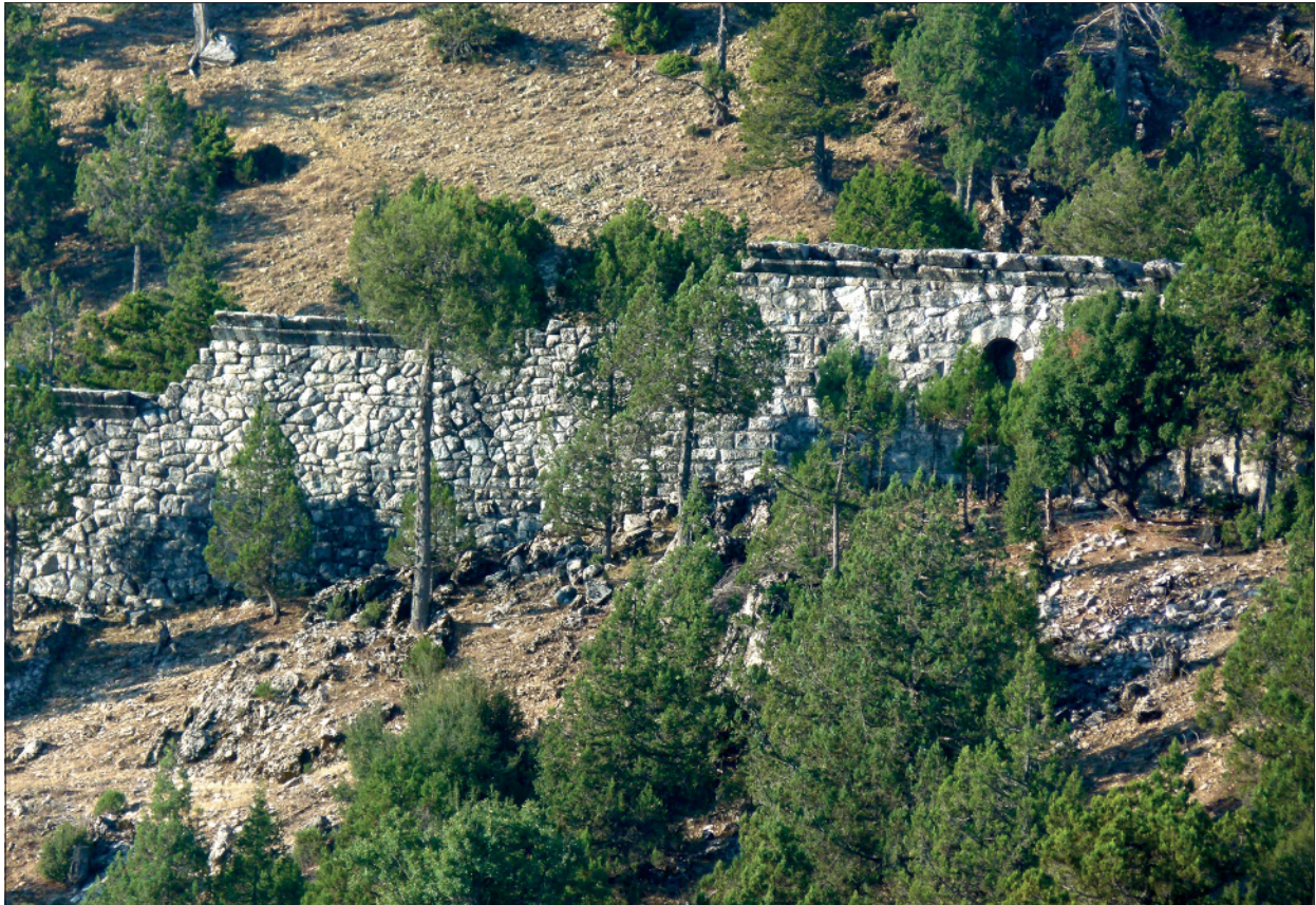
Abb. 4 Südabschnitt der hellenistischen Stadtmauer, Blick von der Stadt auf die Rückseite in Polygonaltechnik. – (Foto Verf.).
