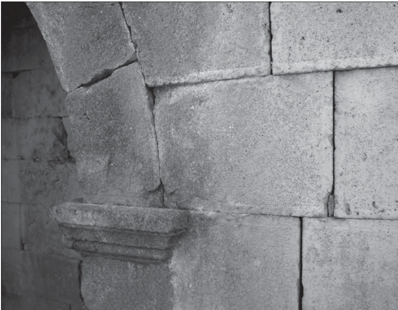
Abb. 10 Saccaea, »Kalybe«, Nordfront, Bogen der unteren Nische, Keilsteine aus wieder verwendeten Quaderblöcken. – (D-DAI-ROM-2011.1728, Foto P. Grunwald, digitale Bildbearbeitung H. Behrens, D. Gauss, G. Barbat).
