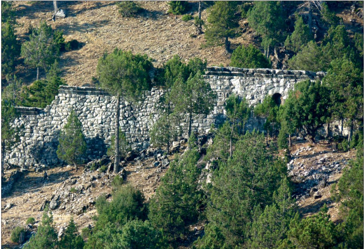
**Abb. 4** Südabschnitt der hellenistischen Stadtmauer, Blick von der Stadt auf die Rückseite in Polygonaltechnik. – (Foto Verf.).
