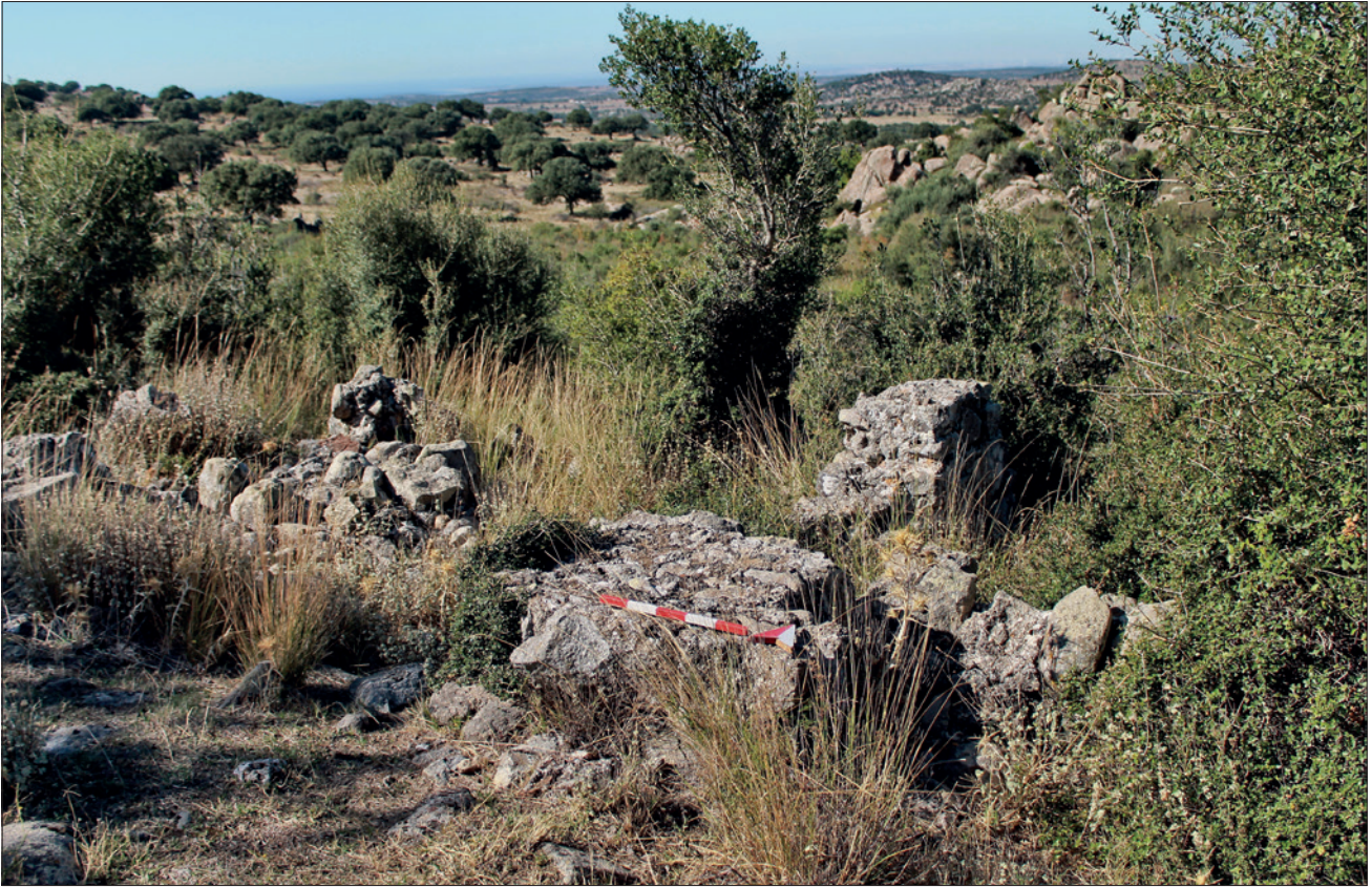
Abb. 21 Mit opus caementitium errichtetes Gebäude im Dorf Işkin. – (Foto B. Böhlendorf-Arslan).
