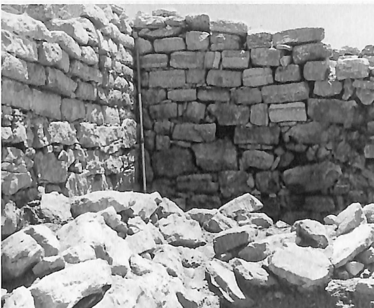
Abb. 21: Akropolis von Smari, Mauerwerk Detailaufnahme
