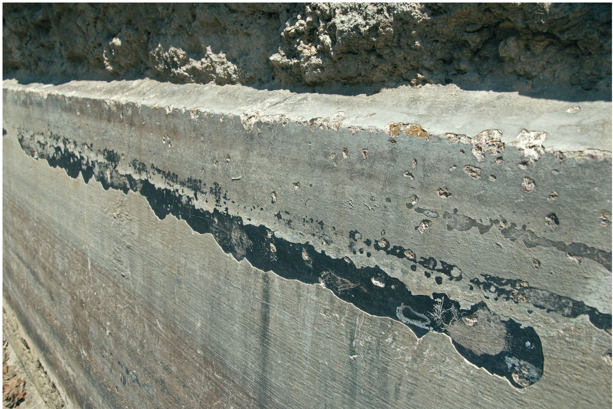
Abb. 11 Wasserleitung für das antike Nîmes unterhalb der Eure-Quelle. Großflächiger Holzascheauftrag an den Seitenwangen des Kanals.
