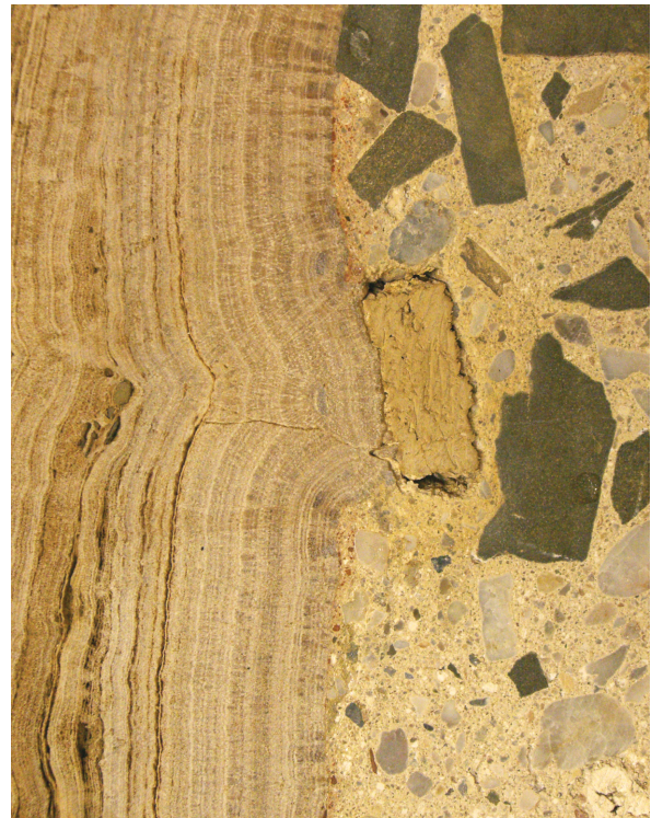
Abb. 3 Eifelwasserleitung bei Rheinbach. Eine Holzleiste des Schalungsbrettes hat sich in das opus caementicium des Wangenmauerwerks eingedrückt.
