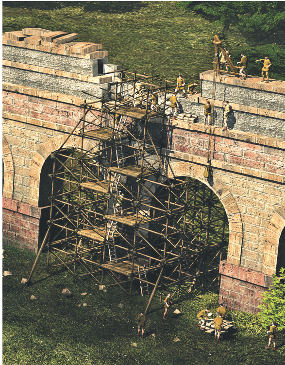
Abb. 1 Bauarbeiten mit Holzgerüsten an der Aqua Marcia (mit Aqua Tepula und Aqua Iulia).
