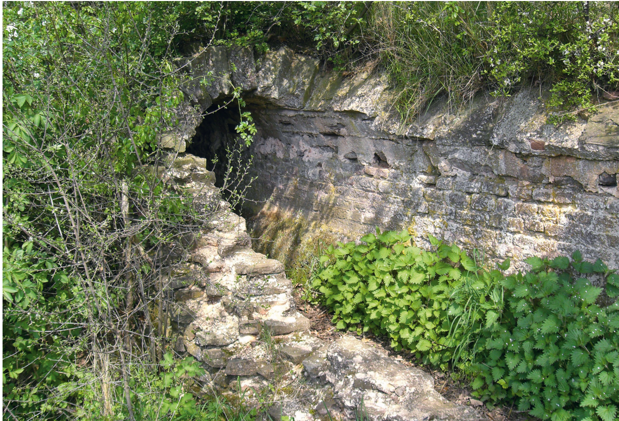
Abb. 4 Eifelwasserleitung bei Mechernich-Breitenbenden. Abdrücke der Schalungsbretter des Lehrgerüsts im Gewölbe der Leitung.
