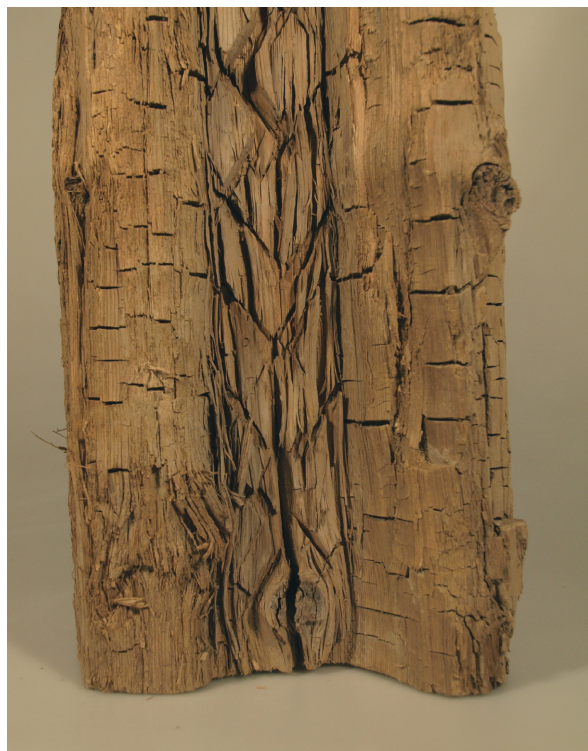
Abb. 8 Nutgrund einer Spundwandkonstruktion aus dem 15. Jahrhundert von Orth an der Donau, mit ähnlichen Werkzeugspuren wie in der Bronzezeit.
