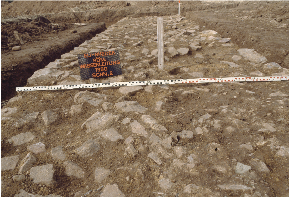
Abb. 5 Eifelwasserleitung bei Euskirchen-Rheder. Im Unterbau der Aquäduktbrücke über die Erft zeigte sich der Hohlraum eines ehemaligen Messpfähchens aus Holz (im Foto nachgestellt).
