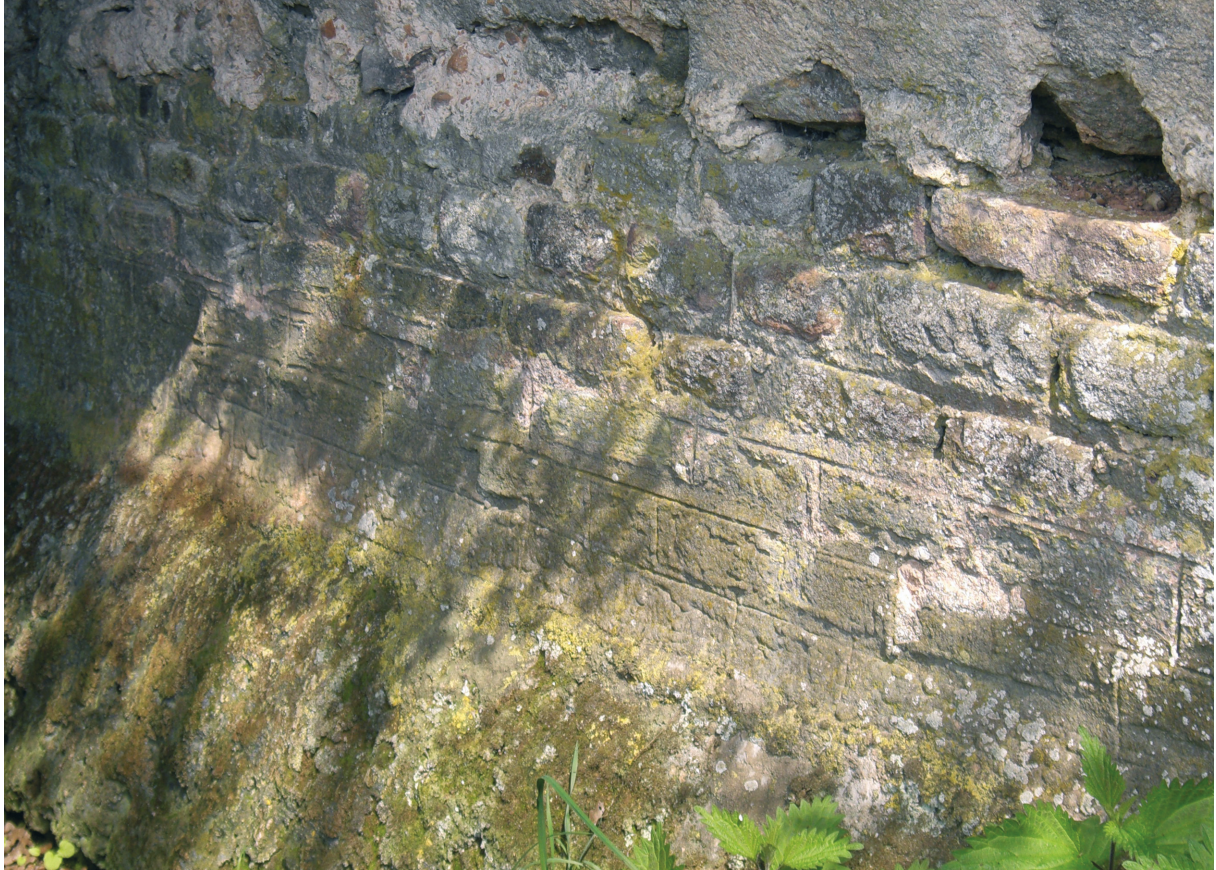
Abb. 2 Eifelwasserleitung bei Mechernich-Breitenbenden. Kanalwanne mit „verlorener“ Schalung. Auffällig sind die in den Steinfugen erkennbaren Zierfugen, einem Zierrat, der während der Betriebszeit der Leitung von Niemandem einzusehen war.
