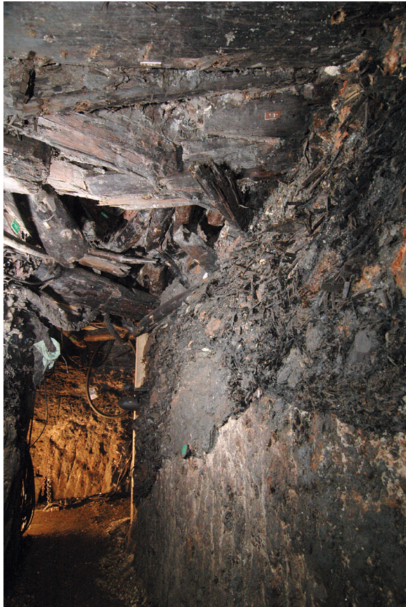
Abb. 1 Grubenhölzer an der First der Grabungsstollen.
