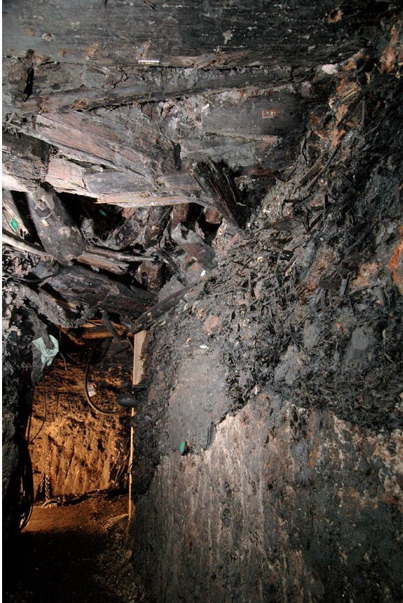
Abb. 1 Grubenhölzer an der First der Grabungstollen.
