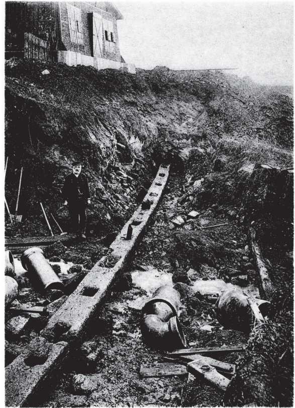
Abb. 11 Zwei 15,85 bzw. 10,30 m lange Balken der Kaiwand des Kastells Stockstadt. Situationsfoto ohne M.
