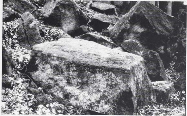
Abb. 12 Mauerley bei Wassenach. Römerzeitlicher Steinbruch II. Überarbeiteter Rohblock, der noch stehende "Bossen" (bruchraue Fläche) des Oberlagers ist von drei Seiten bereits abgearbeitet. Eine mit Randschlag bearbeitete Ecke ist an einem Stich ausgebrochen. Ein weiterer Stich wurde zur Kontrolle aufgepickt, der Block dann aufgegeben. Länge: 1,50 m; Breite: 1,15 m; Höhe: >0,72 m. Nr. H II 21 / Materialaufnahme Mauerley.
