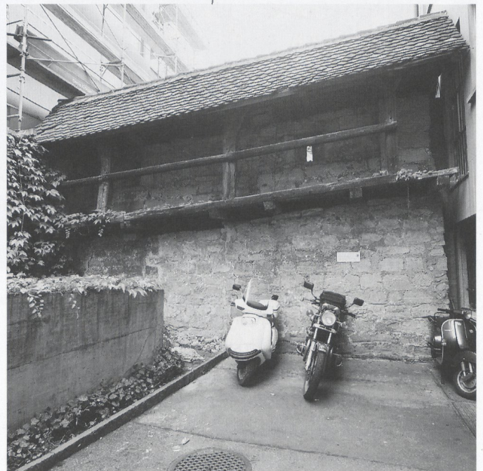
Abb. 162: Bern, Äussere Neuenstadt. Einziger oberirdisch erhaltener Rest der Befestigung der Äusseren Neuenstadt mit jüngerm Wehgang. Er befindet sich an der nördlichen Hangkante unmittelbar östlich des Kunstmuseums. Blick nach Norden.
