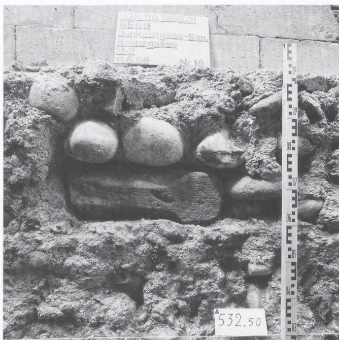
Abb. 114: Bern, Kreuzgasse Süd. Die angebliche Grabengegenmauer einer postulierten gründungszeitlichen Stadtmauer entpuppt sich als in die Grube gemauertes Kellerfundament. Aufgrund der eingemauerten verwitterten Spolie aus dem 13. oder 14. Jahrhundert dürfte der Keller ins 15. oder 16. Jahrhundert zu datieren sein.
