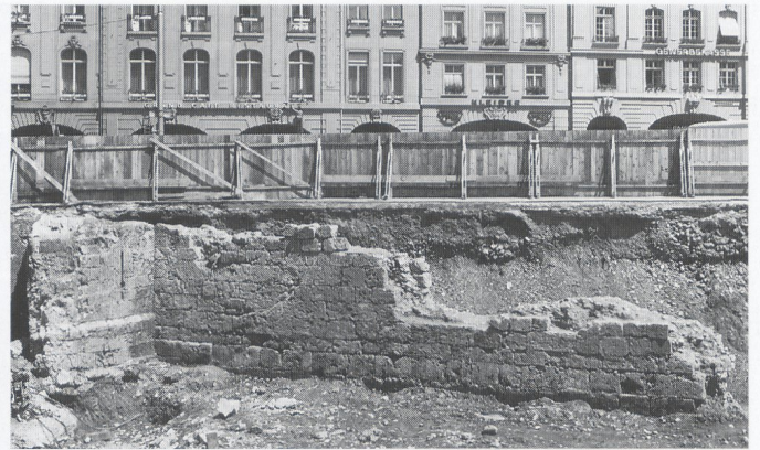
Abb. 161: Bern, Bahnhof-/Bubenbergplatz. Christoffelbefestigung mit innerer Grabenmauer und einem Halbrundturm. Blick nach Nordost.
