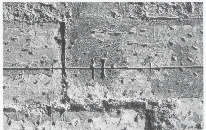
Abb. 121: Bern, Innere Neuenstadt, Dominikanerkloster. Detail der ins Quadermauerwerk der Lettnerrückwand eingehauen Messstrecke.
