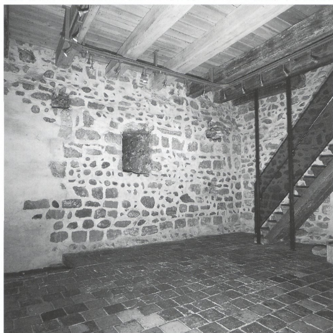
Abb. 131: Bern, Zytgloggeturm. Originales Mauerwerk der ersten Hälfte des 13. Jahrhunderts im ersten Obergeschoss. Blick nach Südwesten
