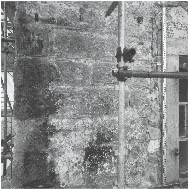
Abb. 137: Bern, Felsenburg. Detail des originalen Bossenquadermauerwerks aus dem mittleren 13. Jahrhundert (Bossen nachträglich abgeschrotet). Blick auf die Nordwestecke.
