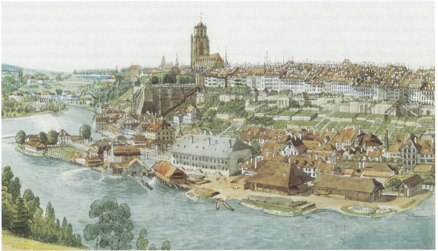
Abb. 166: Bern, Matte. Die Gewerbesiedlung im frühen 19. Jahrhundert. In der Bildmitte mit mächtigem Krüppelwalmdach die rittlings über dem Tych stehende Stadtmühle (Neubau von 1818). Rechts davon liegt die Werft mit Vollwalmdach und davor die ostseitige Schiffflände. Aquarell von Franz Schmid um 1820.
