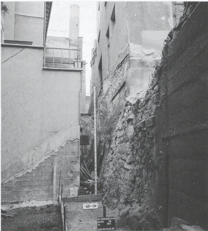
Abb. 63: Freiburg i.Br. Stadtmauer der Gründungsstadt auf dem «Harmonie»-Areal. Aussenseite mit Schürze. Links im Bild Gebäude, die im 19. Jahrhundert in den Graben gestellt wurden. Blick nach Westen.
