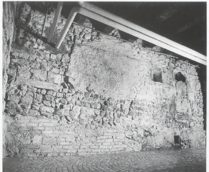
Abb. 65: Freiburg i.Br. Steinerner Kernbau an der Salzstrasse 18 (1140 d), Westfassade mit Tür. Blick nach Südosten.
