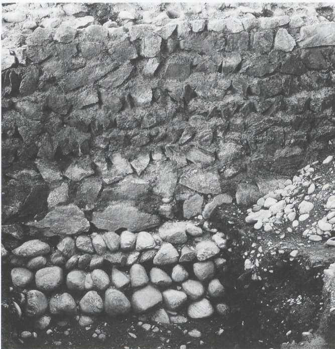
Abb. 64: Freiburg i.Br. Stadtbefestigung der Gründungsstadt auf dem «Harmonie»-Areal, Innenseite. Im Vordergrund die Abschlussmauer der Rondenwegaufschüttung, im Hintergrund die eigentliche Stadtmauer. Blick nach Süden.
